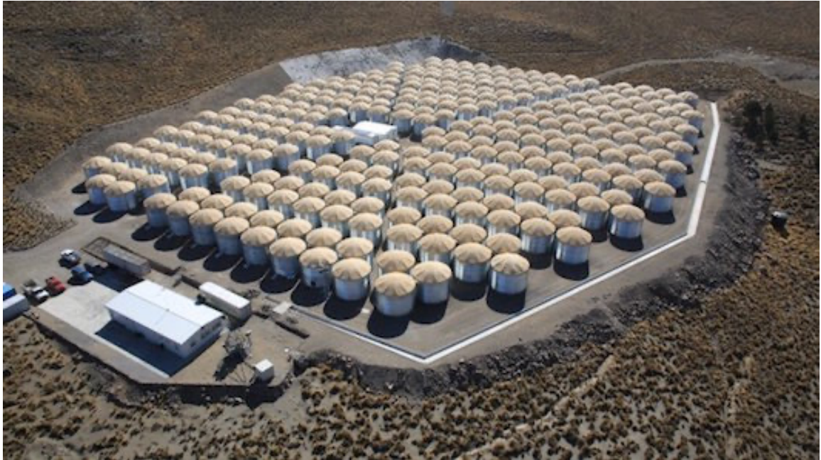
Figura 4 - Vista aérea observatorio HAWC
